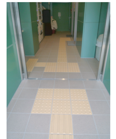
安全交通試験研究センターの点字ブロック
